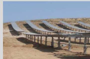
Montagem das mesas dos painéis solares
