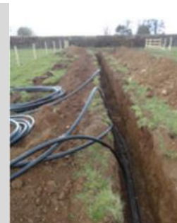
Instalação de cabos elétricos nas valas
