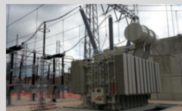
Construção e equipamento da subestação
